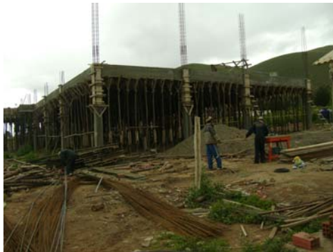
Vista lado Este
