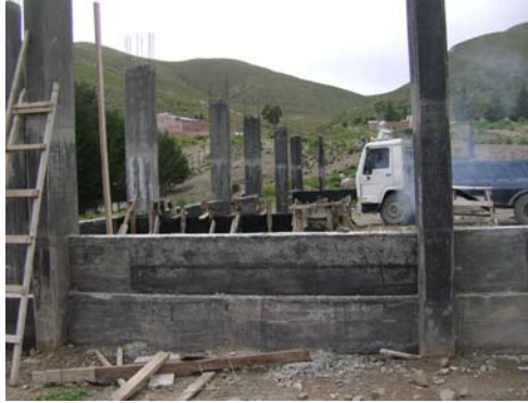
Vista lado Este
