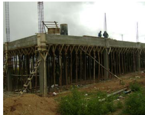
Vista lado Oeste
