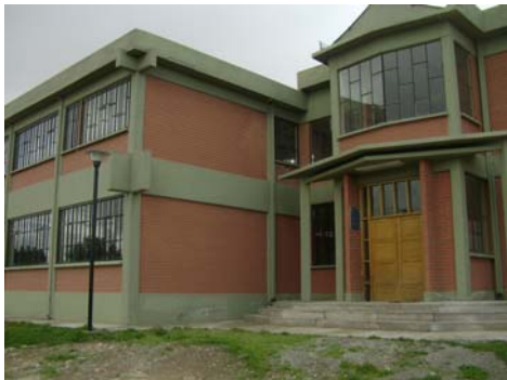
Vista lado Este
