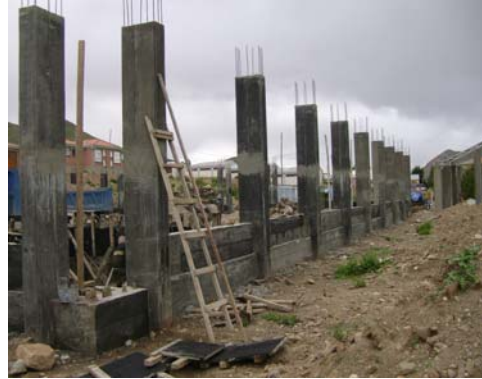
Vista lado Oeste
